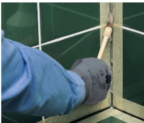
Aanbrengen van Primer FD
