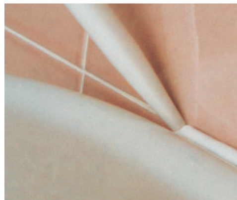
Afdichten van sanitair
